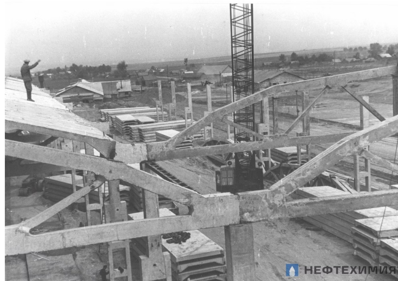
Строительство "Могилевского комбината синтетического волокна" (Фото: Портал «Нефтехимия»)
